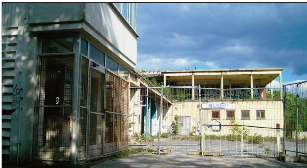
Geschlossenes Restaurant am Müggelturm vor der Sanierung 2013.
