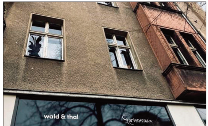
Auch an diesem Haus in der Hauptstraße gingen durch eine Kugelbomben-Explosion viele Scheiben zu Bruch.
