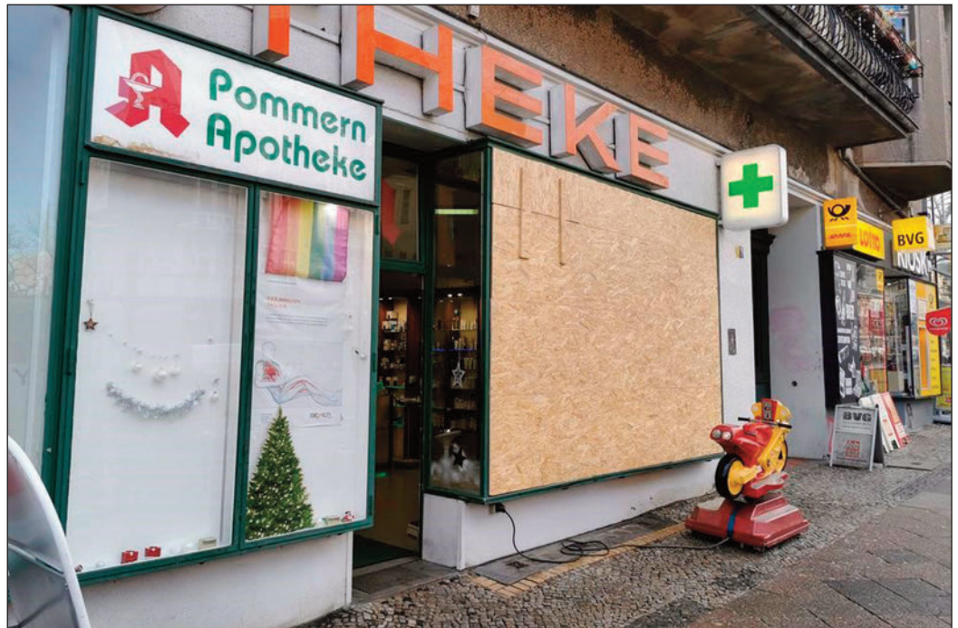
Die zersplitterte Scheibe dieser Apotheke in der Hauptstraße wurde mit einer Spanplatte provisorisch ersetzt.
